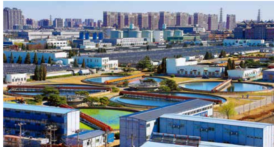
高碑店再生水厂采用世界一流先进工艺，日处理能力达100万吨，承担着北京中心城区及东部地区的污水处理任务，是国内规模最大的再生水厂之一。（张全跃/摄）
