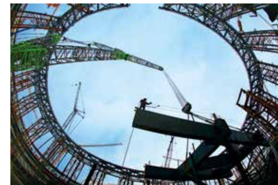
仰视钢结构施工
