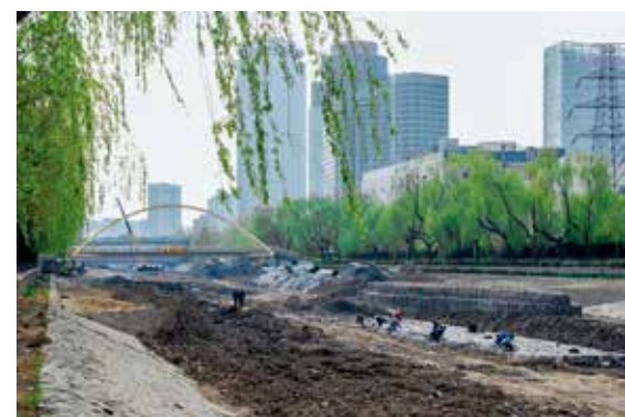
铺设排污管道
