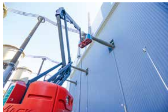
检修人员进行设备检修
