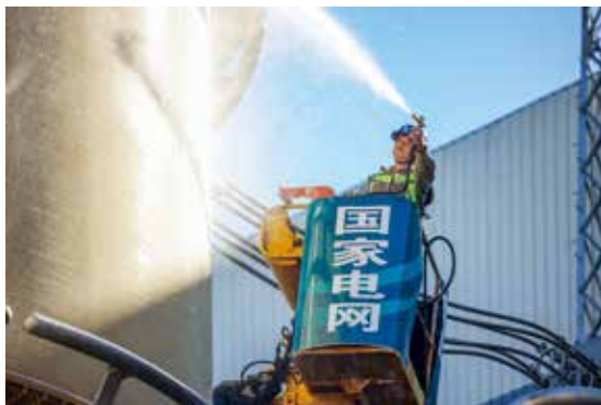
检修人员进行设备冲洗清灰
