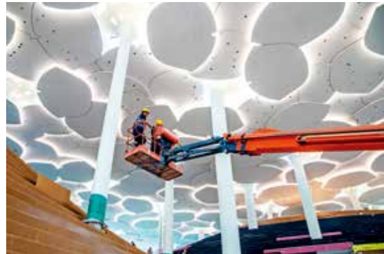
2023年9月，北京城市图书馆主体结构及外立面装修工程已全面完工，随即加速开展室内装修，预计年底面向公众开放。（陈啟亮/摄）
